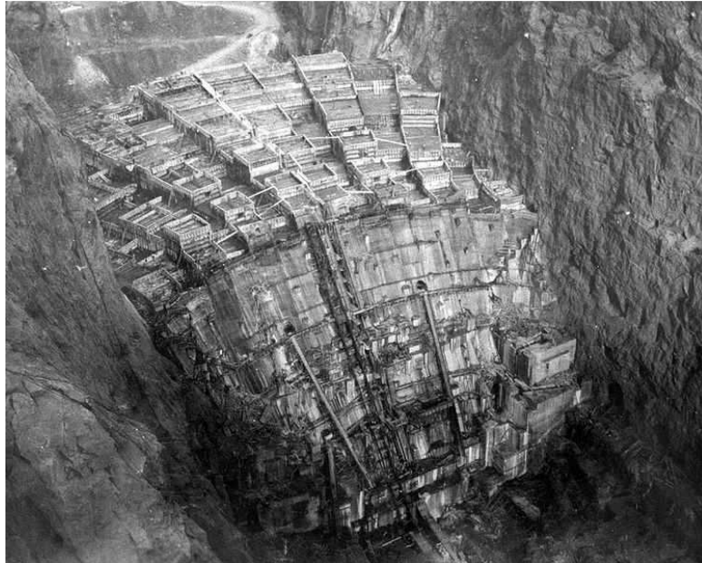
6. kép: Blokkok betonozása
