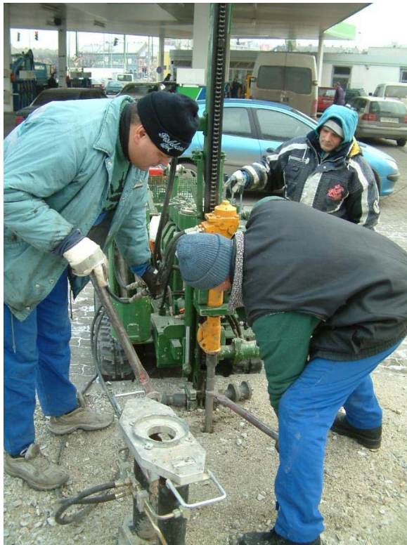
5. ábra: Az ablakos szondaszár leverése hidraulikus verőkalapáccsal történik, a magkihozatal még kedvezőtlen talajviszonyok esetén is – jól megválasztott szonda esetén – 100%-os
