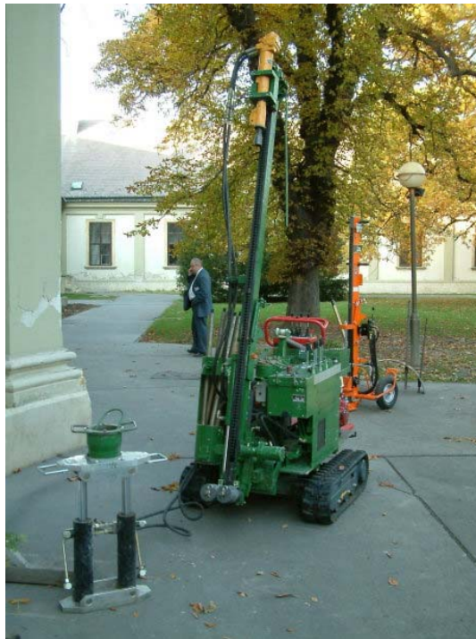
1. ábra: Az MRZB önjáró fúróberendezés a ráckevei Geotechnika'2003 konferencián
