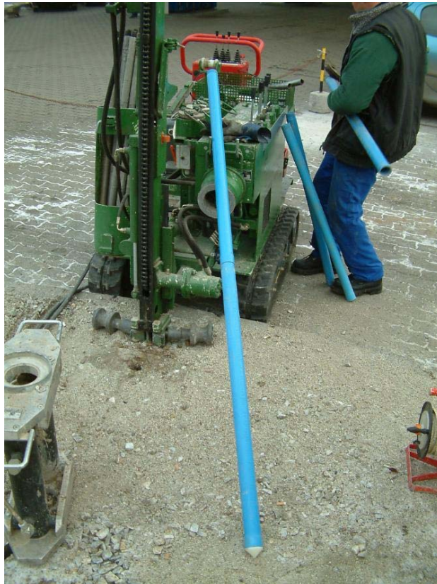
6. ábra: A beépítésre váró polietilén, résezt szűrőcső
