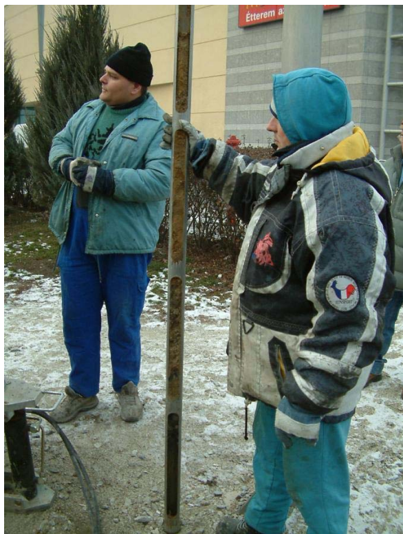
5. ábra: Az ablakos szondaszár leverése hidraulikus verőkalapáccsal történik, a magkihozatal még kedvezőtlen talajviszonyok esetén is – jól megválasztott szonda esetén – 100%-os
