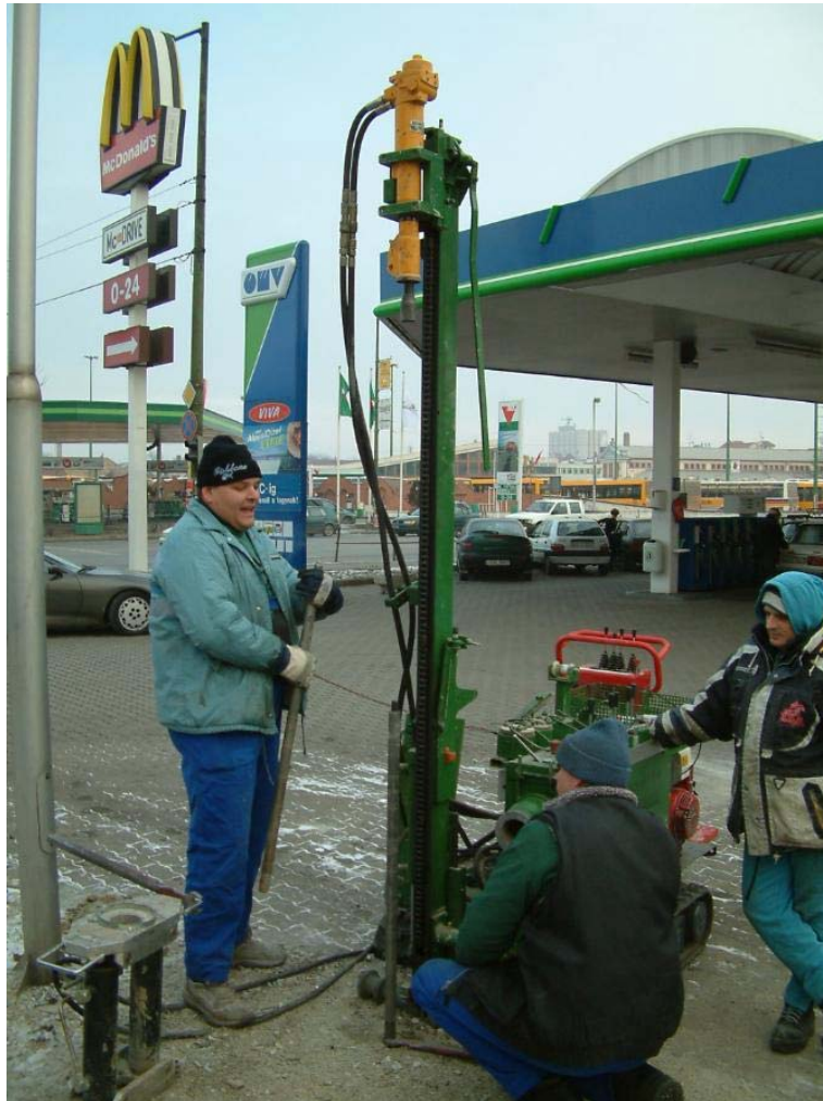
4. ábra: A gép kis magassága miatt lehetőség van tetőkészítők alatti munkavégzésre, ami pl. üzemanyag-töltő állomásokon előnyös
